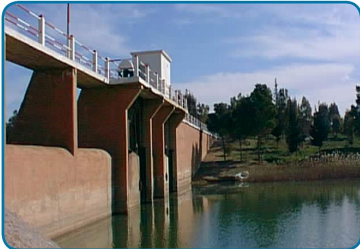
**Le barrage de Boughzoul sur l'Oued Ouassel est situé dans la commune du même nom et constitue une retenue destinée à écrêter les crues au niveau du barrage du Ghrib situé à l'aval. La retenue joue également un rôle décanteur permettant de limiter les apports dans la retenue du Ghrib et comme un réservoir d'accumulation complémentaire.**
