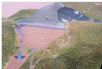
ment en rip-rap. Le pied aval du barrage est réalisé en enrochement.
