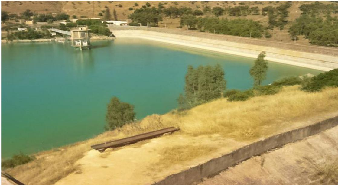
Le barrage du Ghrib est situé dans la commune de Oued-Chorfa (Ain-Defla). Il est implanté sur l'Oued Chélif, à 20 kilomètres au sud-ouest de la ville de Ain-Defla. Ce barrage est destiné à l'irrigation, l'AEP et le transfert vers le barrage de Bouroumi (SAA) pour un volume régularisé annuel de 105 millions de m<sup>3</sup>.
