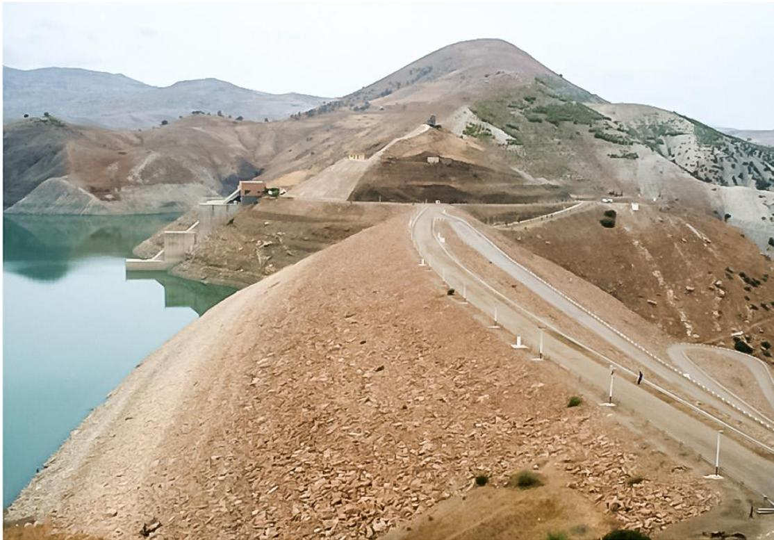
Le barrage de Sidi Yacoub est situé sur l'Oued Ardjem, à 20 kilomètres au sud de la ville d'Oued Fodda (Chlef). L'ouvrage, d'une capacité de 286 Hm<sup>3</sup>, est destiné à l'irrigation d'un périmètre de 10.000 ha environ et à l'alimentation en eau potable de la wilaya de Chlef.
