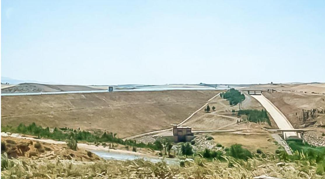
Le barrage de Lekhal est situé sur l'Oued Lekhal (Bouira). L'ouvrage est destiné à l'alimentation en eau potable et industrielle des régions d'Ain-Bessem et Sour -el-Ghozlane, ainsi qu'à l'irrigation des plaines des Arribs. La retenue créée par le barrage a une capacité utile de 29.993 hm<sup>3</sup>, permettant la régularisation annuelle de 25.5 hm<sup>3</sup>.
