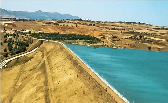
Le barrage est situé sur l'Oued Ladrat (Médéa). L'ouvrage est destiné à l'irrigation du périmètre de Tiara. La retenue créée par le barrage a une capacité utile de 10 hm<sup>3</sup> permettant une régularisation de 7.5 hm<sup>3</sup>. La mise en service de l'ouvrage date de 1989.
