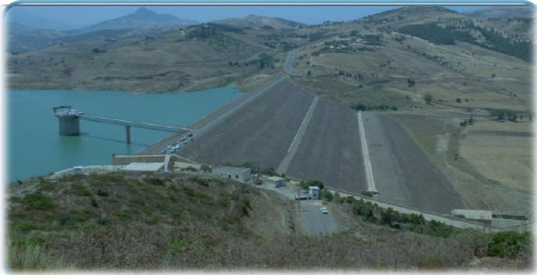
Le barrage de Boukourdane est situé sur l'Oued El Hachem, dans le territoire de la wilaya de Tipasa. L'ouvrage a une capacité de 104,999 hm<sup>3</sup> avec un volume régulariser de 70.5 hm<sup>3</sup>/ans. Il est destiné à l'alimentation en eau potable de Cherchell, Tipasa et Nador, ainsi qu'à l'irrigation de la vallée de l'Oued el Hachem et des régions de Hadjout et du Sahel.
