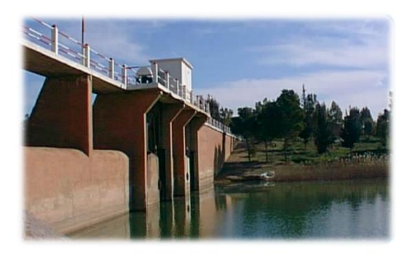
Le barrage de Boughzoul sur l'Oued Ouassel est situé dans la commune du même nom et constitue une retenue destinée à écrêter les crues au niveau du barrage du Ghrib situé à l'aval. La retenue joue également un rôle décanteur permettant de limiter les apports dans la retenue du Ghrib et comme un réservoir d'accumulation complémentaire.
