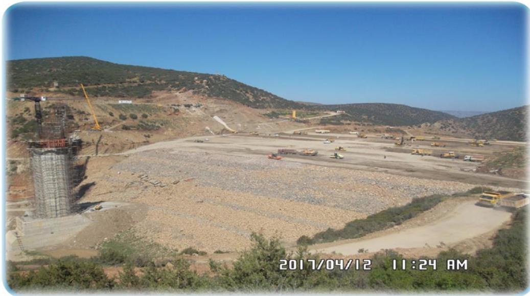
Le barrage est situé dans la wilaya de Médéa, à environ 7 km au sud de la ville de Beni Slimane. Il aura pour objectif de stocker et régulariser les apports de l'oued Mellah, dans la wilaya de Médéa, ayant comme fin d'irrigation. Le barrage formera une retenue d'un volume utile de 28 hm<sup>3</sup>, à la cote de retenue normale 715,00, avec un volume régularisé de 6,7 hm<sup>3</sup>/an. Ce débit régularisé sera utilisé pour irriguer la zone à l'aval.
