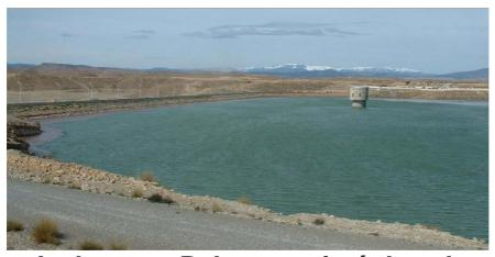
Le barrage Babar est situé dans la wilaya de Khenchla à 30 Km de ladite ville et à 9 km au sud-ouest de la ville de Babar. Réalisé sur le bassin fermé de l'Oued El Arab, ce barrage est destiné à la régularisation des apports de l'Oued El Arab en vue d'irriguer les terres environnantes.
