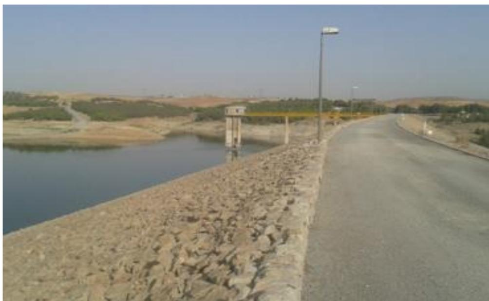
Le barrage d'Ain Zada est une digue en terre à noyau argileux incliné supporté par deux recharges en enrochement. Les deux matériaux sont séparés par un filtre à deux zones. Sa capacité est de 125 millions de m<sup>3</sup> pour une hauteur de digue de 35 mètres.
