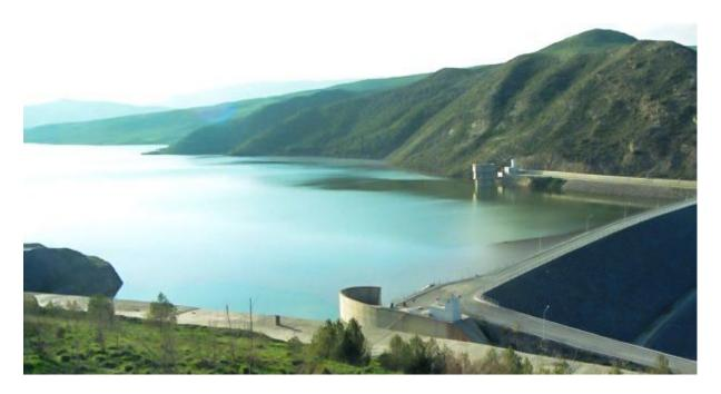
La digue est constituée d'un remblai en enrochements compactés de pente moyenne à l'amont de 2,1/1 et à l'aval de 2/1. Les risbermes situées respectivement aux niveaux 700 m et 685 m de largeur 5 m et 8 m. la côte de la crête et de 715,50 d'une largeur 9 m, avec une longueur de 300 m ; dans le plan horizontal, la crête de la digue présente une courbure vers l'amont de 1500 m de rayon.
